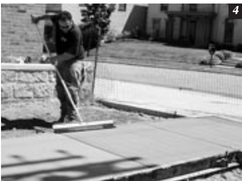
1—strikeoff; 2—mag hand floating; 3—bull floating; 4—brooming
